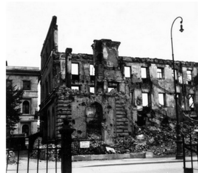
Braunes Haus, Brienner Straße 45, Ansicht der Ruine nach den Kriegszerstörungen 1946/1947. (Bayerische Staatsbibliothek, Bildarchiv hoff-61118 )
